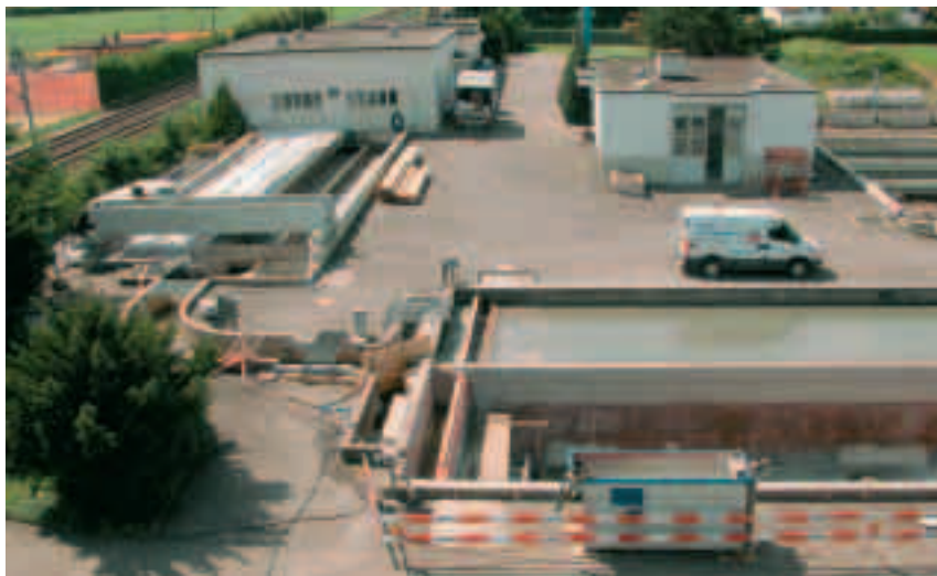
Abb. 1 Sanierung der Vorklär- und Sandfangbecken der ARA Freienbach.
